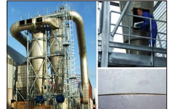
Después de ensamble en el lugar repetir la imprimación y revestimiento sobre los ID de las bridas y soldadura.
