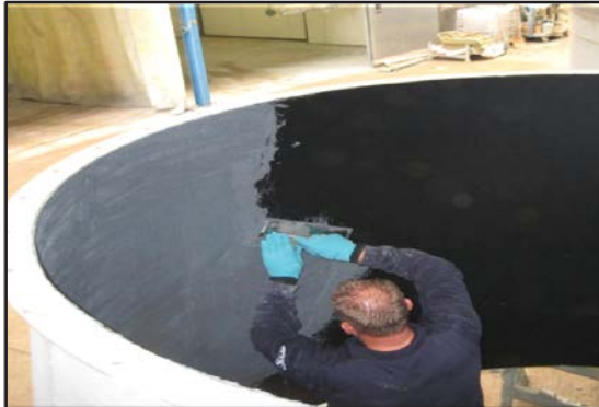
Después de limpieza, ARC 855 de imprimación se aplica con rodillo y luego ARC BX1 , finalizando con ARC BX2 .
